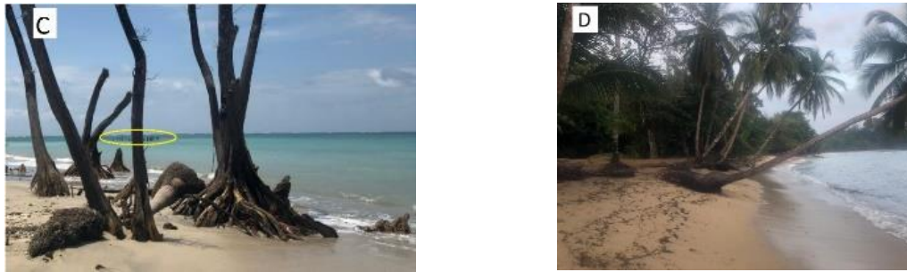
Fig. 2. Fotografías que evidencian erosión en playas del Caribe de Costa Rica. A: Playa Moín, diciembre del 2018, B: Playa Cieneguita, diciembre del 2015, C: Puerto Vargas, abril 2021 y D: Punta Uva, abril del 2021. En la Fig. 1C se señala con una elipse amarilla los escombros en el mar. Elaboración propia.
