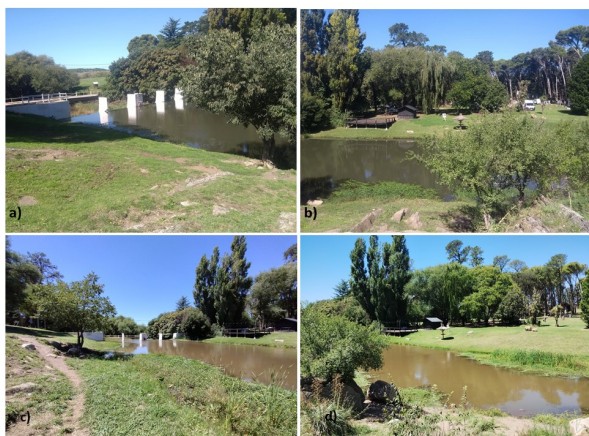
Figura 7. M5 en 2022 (7a y 7b) y 2024 (7c y 7d) donde se observa el dique y la disminución del caudal del arroyo El Belisario. Fuente: fotografías de las autoras
