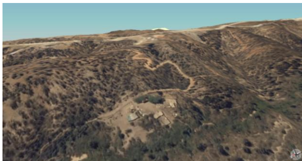
Figura 23. Vista de viviendas con dificultad de acceso
