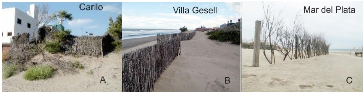
Fig. 7. En algunas localidades los enquinchados se utilizan en propiedades del dominio privado (A). En el Partido de la Costa y Villa Gesell fueron utilizadas en largos tramos como política de defensa municipal (B). En Mar del Plata, se han utilizado para fijar las rampas de dunas en los balnearios del sur (C).
